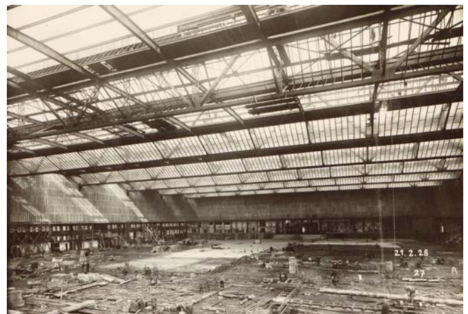
Bild 17. Fertigstellung der Gebäudehülle Fig. 17. Finishing the envelope of the building
