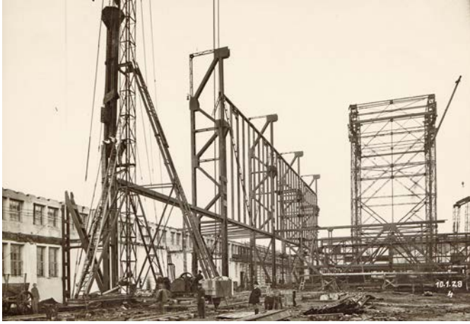
Bild 12. Montage der nordwestlichen Längswand Fig. 12. Erection of the North-western longitudinal wall
