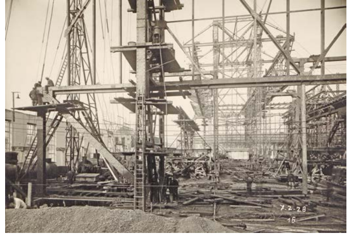
Bild 15. Montage der Hauptdiagonale der Längsaussteifung Fig. 15. Assembly of the main diagonal of the longitudinal bracing
